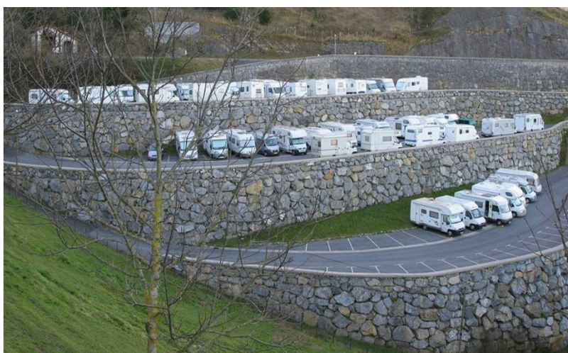
Parking N.S.de Aranzazu, Gipuzkoa (Foto V.Acuña)
