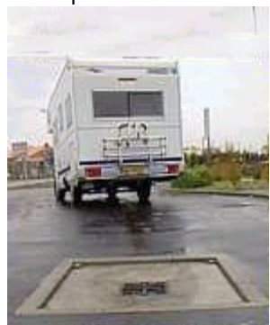
Rejilla de vaciado + grifo de agua
